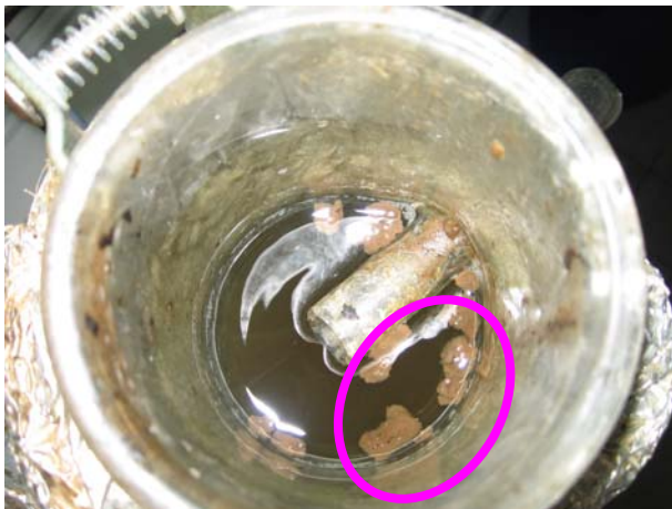
Bild 4.5 Schwimmschlamm in der Nachklärung der EMa-Anlage in der Form größerer Pellets (rote Markierung)
